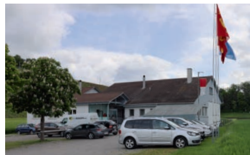
Die Schiessanlage Riet Kleinandelfingen
